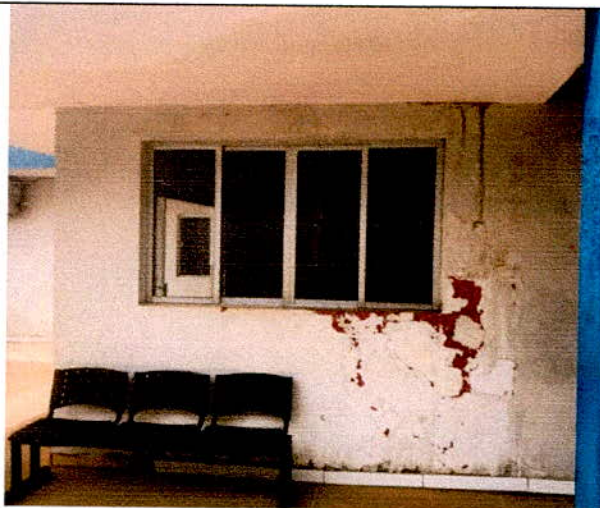
FIGURA 02- Infiltração
