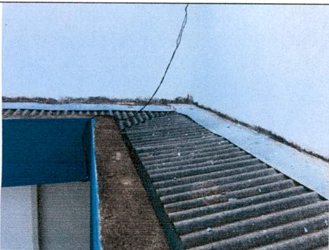
FIGURA 09- Cobertura de laje externa
