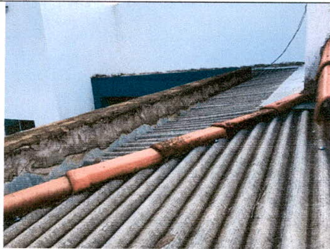
FIGURA 10- Cobertura de laje externa
